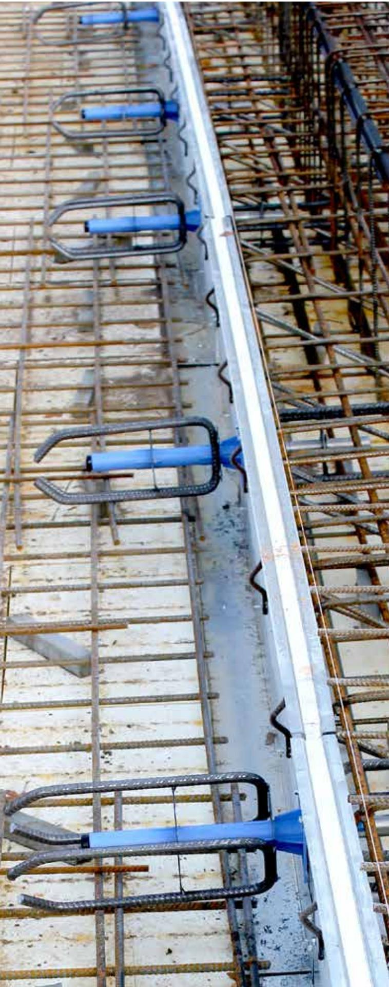
Dehnfugen werden im Hoch- und Tiefbau geplant, um Schrumpf- und Dehnungsbewegungen aufgrund seismischer Faktoren, Temperaturschwankungen und Abbinden des Betons zu absorbieren. Sie ermöglichen Bewegungen der tragenden Elemente, ohne dass Risse oder Sprünge entstehen.
